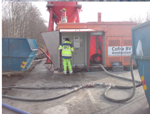
Grundvattenbarriär vid vägskärningar under grundvattenytan.
