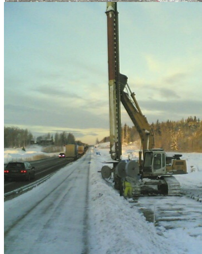
Projekt: Väg E18 Västerås Mängd: 120 000 m Januari 2007 Mebradrain 7007 Beställare: Vägverket produktion
