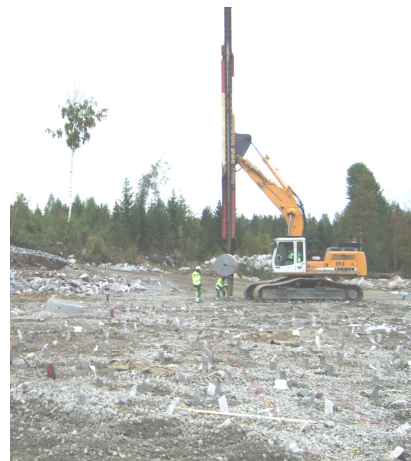
Projekt: Väg E4, Enånger Mängd: 350 000 m Juni - September 2008 Mebradrain 7007 Beställare: NCC Construction
