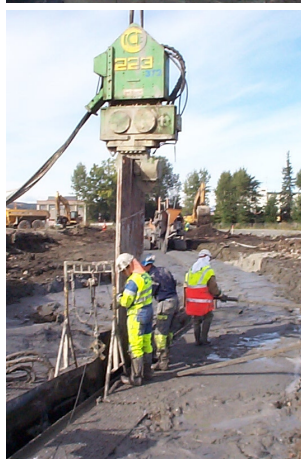
Grundvattenbarriär vid vägsärningar under grundvattenytan.
