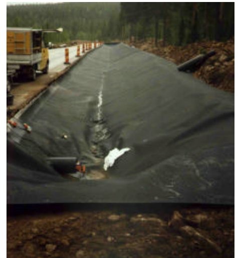
Grundvattenskydd med Geomembran i vägdike.
