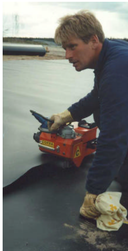
Svetsning av GSE Geomembran med dubbel fusionssvets.
