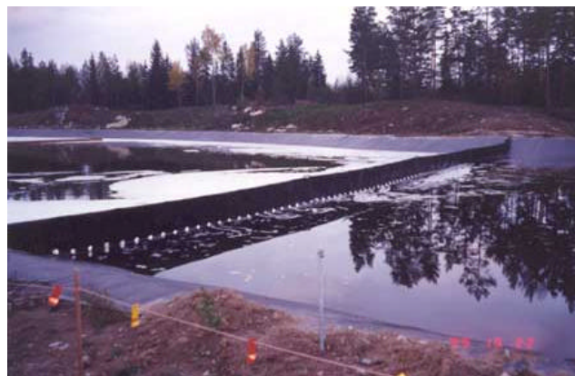
Bottentätning av slambassänger.
